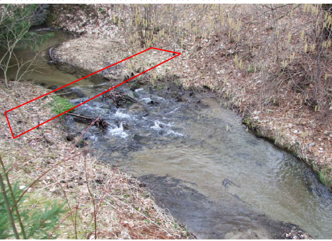
FOTO S VYZNAČENÍM ÚPRAV (ZVÝŠENÍ SKLONU ZA STUPNĚM PRO ZVÝŠENÍ VZDUŠNÍ NA PŘELIVNOU HRANU STUPNĚ)
